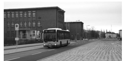
Es ist nicht lange her, da plante man noch eine neue Straßenbahnstrecke zwischen Berlin-Schöneweide und Adlershof und hat dafür eine eigene Trasse (der Sandstreifen rechts) in der Mitte des neuen Groß-Berliner Damms freigehalten. Heute wird die großzügig dimensionierte Straße von der sinnvoll veränderten Buslinie 163 bedient, allerdings nur zu ausgewählten Zeiten. Ausgerechnet zu den Stunden, in denen hier das höchste Verkehrsaufkommen zu erwarten wäre, verkehrt sie nicht. Soll bewiesen werden, dass man die Straßenbahn nicht braucht? (Foto: Raul Stoll)
