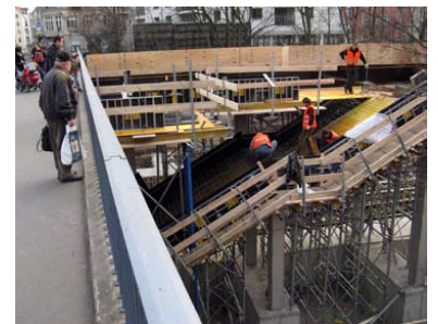
S-Bahnstation Kolonnenstraße im Bau. Man hätte es kaum geglaubt: Die seit 1987 versprochene Station nimmt Form an. Sie soll am 30. April 2008 eröffnet werden. (Foto: Kay Röllig)
