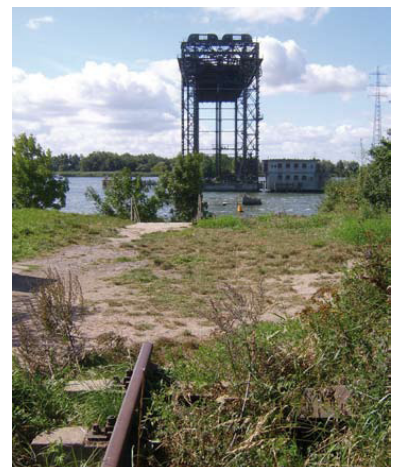
Karniner Eisenbahnbrücke der ehemaligen Eisenbahnverbindung Berlin--Angermünde--Ducherow--Karnin--Swinemünde--Seebad Heringsdorf. (Foto: Florian Müller, September 2007)
