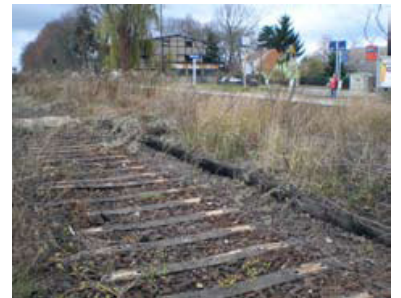
Abgebautes Gleis im Bahnhof Golzow auf der Ostbahn. Eine vielfach nur geringe Kapazität weisen die grenzüberschreitenden Strecken Richtung Polen auf. Verschärft wurde die Situation in den letzten Jahren durch Infrastrukturrückbau. (Foto: Christian Schultz, November 2007)
