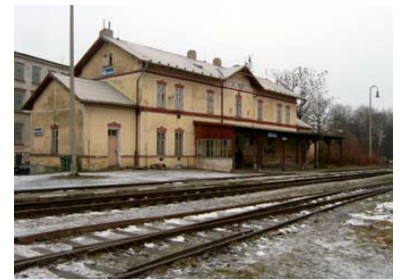
Bahnhof As in Tschechien. Hier zweigt die Strecke nach Selb-Plößberg in Franken ab. Eine Reaktivierung der Strecke würde die Region besser zusammenbringen. (Foto: Florian Müller, 2005)
