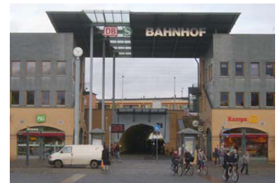
Der Bahnhof Hennigsdorf (b Berlin) ist im »Kernportfolio« und wurde schon 1998 mit der S-Bahn-Wiedereröffnung völlig umgestaltet. (Foto: Florian Müller)
