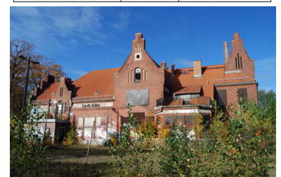
Bahnhof Caputh-Geltow bei Potsdam. Das Empfangsgebäude steht leer und verfällt - wie viele andere Bahnhofsbauten der DB. (Foto: Rüdiger Herzog)
