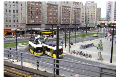
Neubaustrecke mit Rasengleis in der Karl-Liebknecht-Straße Ecke Dircksenstraße. Noch nicht neu ist die Schaltung der Ampelanlagen, weshalb die Straßenbahnzüge derzeit noch zu häufig und zu lange stehen müssen. (Foto: Marc Heller)
