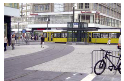
Fehlplanung. Die Verbindung von der Neubaustrecke in der Dircksenstrasse zur vorhandenen Strecke auf dem Alexanderplatz ist durch einen falsch platzierten U-Bahn-Aufzug nur eingleisig und damit nur sehr eingeschränkt nutzbar. (Foto: Florian Müller)
