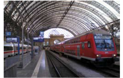
Der Dresdener Hauptbahnhof wurde umfassend saniert. Aber die Instandhaltung und der Ausbau der Bahnstrecke von Dresden nach Berlin kommen trotz der internationalen Bedeutung dieser Trasse nur schleppend voran. Ein Abschluss ist nicht absehbar. (Foto: Christian Schultz)
