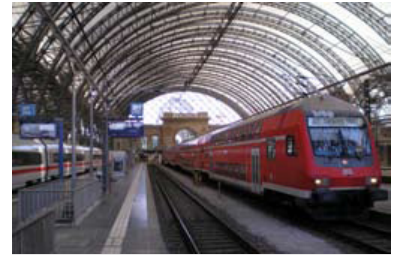
Der Dresdener Hauptbahnhof wurde umfassend saniert. Aber die Instandhaltung und der Ausbau der Bahnstrecke von Dresden nach Berlin kommen trotz der internationalen Bedeutung dieser Trasse nur schleppend voran. Ein Abschluss ist nicht absehbar. (Foto: Christian Schultz)
