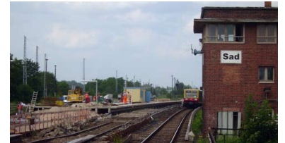
Behelfsbahnsteig Adlershof beim Aufbau (Foto: Florian Müller)
