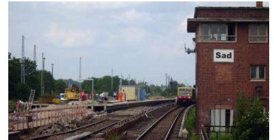
Behelfsbahnsteig Adlershof beim Aufbau (Foto: Florian Müller)
