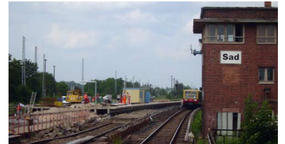
Behelfsbahnsteig Adlershof beim Aufbau (Foto: Florian Müller)
