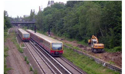
Noch kein S-Bahnhalt, aber schon mal eine Langsamfahrstelle: Bagger sind aufgefahren, um den Bahnsteig des einstigen Bahnhofs Kolonnenstraße abzutragen. Wenn nichts dazwischen kommt, können am 30. April 2008 die Fahrgäste den Eröffnungszug besteigen. Sie warten darauf bereits seit 1987. (Foto: Florian Müller, 23. Mai 2007)
