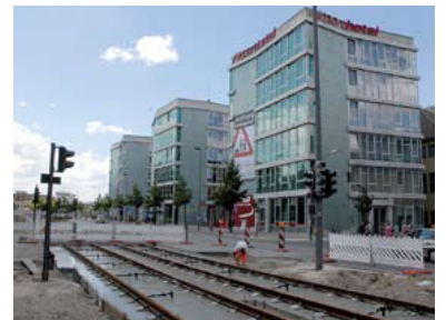
Rudower Chaussee Ecke Groß-Berliner Damm. Der Bau der Straßenbahnverlängerung in die Wissenschaftsstadt Adlershof schreitet zügig voran und dokumentiert eindrucksvoll, wie schnell Straßenbahnbau im Vergleich zum U-Bahn-Bau sein kann. Und schwarze Haltestellen sind hier mit Sicherheit nicht zu befürchten. (Foto: Marc Heller (Juni 2008))
