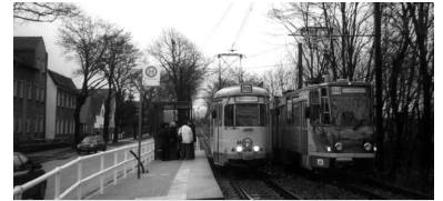
Straßenbahn-Endstelle Alt-Rüdersdorf bei der offiziellen Eröffnung. Beim Bau hat die SRS zum Glück nicht das Ausweichgleis in der Schleife eingespart. Ebenso erfreulich ist der hohe Standard der Haltestellen auf allen modernisierten Abschnitten. (Foto: Artur Frenzel)
