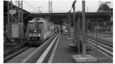
Darmstadt Hauptbahnhof. Seit Jahren wird viel Geld für die Aufwertung des Bahnhofs und des Umfelds eingesetzt. Nun wird die Stadt für ihr Engagement belohnt: Die neue Hochgeschwindigkeitstrasse Frankfurt--Mannheim wird nicht mitten durch Darmstadt führen, aber der Hauptbahnhof erhält ein Verbindungsgleis zur Neubaustrecke. (Foto: Pro Bahn & Bus)
