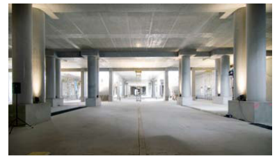
Blick in den neuen unterirdischen Flughafenbahnhof BBI Terminal. (Foto: Marion Schmieding, Alexander Obst/Berliner Flughäfen)
