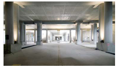
Blick in den neuen unterirdischen Flughafenbahnhof BBI Terminal. (Foto: Marion Schmieding, Alexander Obst/Berliner Flughäfen)
