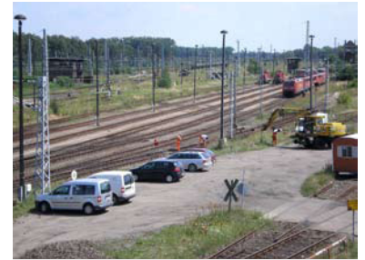
Impulse für den Schienengüterverkehr statt Demontage von Infrastruktur: Die überwiegend brach liegenden Bahnanlagen des Rangierbahnhofs Wustermark an der Strecke Berlin--Rathenow werden schrittweise durch die Rail & Logistik Center Wustermark GmbH & Co. KG wieder in Betrieb genommen. (Foto: Christian Schultz (Juli 2008))
