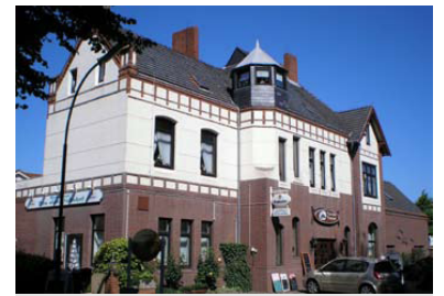
Empfangsgebäude des ehemaligen Bahnhofs von Burg/Fehmarn. Die neue Station Fehmarn-Burg wird etwas nördlicher gebaut. (Foto: Christian Schultz (Juli 2008))
