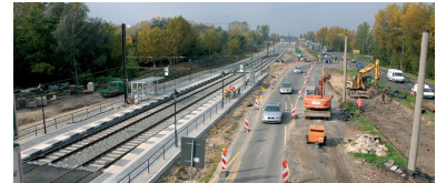
Blick auf die Nuthestraße in Richtung Humboldtbrücke mit der Straßenbahnhaltestelle Humboldtring/Nuthestraße. In diesem Abschnitt wurde die Straßenbahn von der Mittellage (rechts im Bild) in die Seitenlage gebracht. (Foto: Marc Heller (Oktober 2008))
