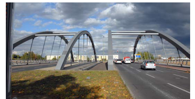
Stubbenauchstraße mit Massantebrücke über den Teltowkanal. Beim Brückenneubau wurde bereits eine Trasse für die Straßenbahnneubaustrecke von Johannisthal nach Rudow (U-Bf Zwickauer Damm) berücksichtigt. Ansonsten wird an diesem die alte Grenze von Ost- nach West-Berlin überschreitenden Projekt ebenso wenig gearbeitet wie an allen anderen Straßenbahnprojekten. 19 Jahre nach dem Mauerfall ist die Bilanz des Berliner Senats hinsichtlich der Straßenbahn erbärmlich. (Foto: Marc Heller (Oktober 2008))
