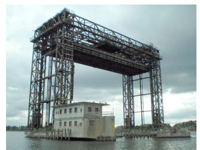
Eisenbahnhubbrücke bei Karnin, 1933 fertig gestellt und bereits 12 Jahre später nicht mehr nutzbar, nachdem die Wehrmacht die zuführenden Brücken gesprengt hatte. (Foto: Christian Schultz)
