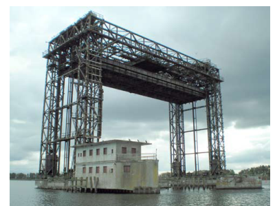
Eisenbahnhubbrücke bei Karnin, 1933 fertig gestellt und bereits 12 Jahre später nicht mehr nutzbar, nachdem die Wehrmacht die zuführenden Brücken gesprengt hatte. (Foto: Christian Schultz)
