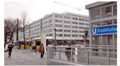
Vorbildlich: Nach anderthalbjähriger Bauzeit wurde Ende November am U-Bahnhof Frankfurter Tor der neue U-Bahn-Zugang an der Straßenbahnhaltestelle in Betrieb genommen. Die Baukosten von ca. 2,5 Mio Euro sind überaus sinnvoll investiertes Geld, denn für die zwischen der U 5 und den Straßenbahnlinien M 10 und 21 umsteigenden Fahrgäste verkürzt sich durch den direkten Zugang zum U-Bahnsteig der Umsteigeweg deutlich. Und durch den Bau von zwei Aufzügen ist der Zugang zum U-Bahnhof nun auch behindertengerecht. (Foto: Marc Heller)
