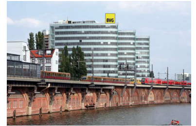
Die BVG zieht um und wird Nachbar des Fahrgastzentrums im S-Bahnhof Jannowitzbrücke. Im August 2008 wird sie in die sogenannten Trias-Towers unmittelbar am Stadtbahnviadukt ziehen, die viele Jahre von der DB genutzt wurden. Der Mietvertrag läuft bis 2040. Die BVG-eigenen Gebäude an der Potsdamer Straße am Kleistpark und an der Rosa-Luxemburg-Straße am Alexanderplatz werden verkauft. (Fotos/Montage: Raul Stoll)
