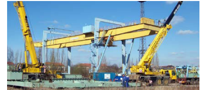
Demontage des stillgelegten Containerbahnhofs Zwickau. (Foto: EFWO)
