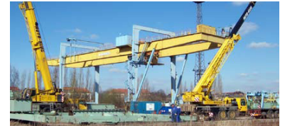
Demontage des stillgelegten Containerbahnhofs Zwickau. (Foto: EFWO)
