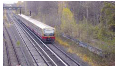
Bereits von 1881 bis 1944 hielten etwa an der Stelle des heute geplanten Bahnhofs die Züge der Ringbahn auf der Spitzkehre zum Potsdamer Bahnhof. Rechts sind die Reste des Ringbahnsteigs noch heute deutlich zu erkennen - bis sie wohl durch die Bauarbeiten beseitigt werden. (Foto: Florian Müller)
