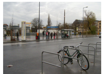
Bushaltestelle Berlin Hauptbahnhof in der Invalidenstraße. Ein völlig unterdimensioniertes Wartehäuschen, viel frischer Wind und eventuell auch eine Regendusche empfangen den Busfahrgast. Die neugepflanzten Bäume behindern beim Betreten des Fahrzeuges. Hier muss schnellstens Abhilfe geschaffen werden! (Foto: Florian Müller)
