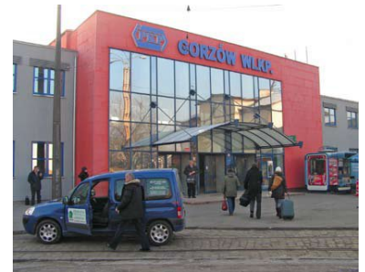
Bahnhof Gorzów Wlkp. Nach Abschluss der Außensanierung im November 2008 erfolgt nun bis Juli 2009 der Umbau der Innenräume. Dabei werden auch neue Fahrgastinformationssysteme und Personenaufzüge eingebaut. Warteräume und Gastronomie bieten künftig eine hohe Aufenthaltsqualität. (Foto: Karl-Heinz Boßan)
