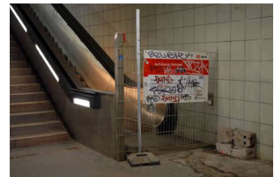
Bundesplatz. Seit Monaten ist die DB-Fahrtreppe von der U 9 (Bahnsteig Richtung Osloer Straße) zum S-Bahn-Ring außer Betrieb. (Fotos: Marc Heller)
