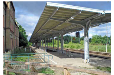
Bahnhöfe sind die Visitenkarten für den Schienenverkehr! Im Bahnhof Müncheberg (Mark) an der Strecke Berlin--Kostrzyn (Küstrin) wurden mit der Sanierung des Bahnsteigdaches zwischenzeitlich erste Verbesserungsmaßnahmen umgesetzt, weitere werden auch hier aus Mitteln der beiden Konjunkturpakete realisiert. (Foto: Christian Schultz (Juni 2009))
