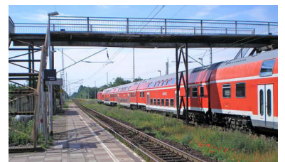
Im Gegensatz zu Vorzeigeprojekten wie Berlin Hbf bieten viele Bahnhöfe in der Region ein erbärmliches Bild, so auch im zur Stadt Zossen gehörenden Dabendorf an der Strecke Berlin--Dresden. Mit den beiden Konjunkturprogrammen werden viele überfällige Verbesserungsmaßnahmen auf bundesweit rund 2050 Bahnhöfen endlich umgesetzt. (Foto: Christian Schultz (Juni 2009))
