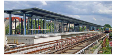
Der im Bau befindliche S-Bhf Adlershof mit Dach auf ganzer Länge! An vielen anderen wichtigen Stationen wurde bei der Modernisierung durch DB Station & Service auf eine minimale Dachlänge geachtet (Charlottenburg) oder das Dach ganz weggespart (Falkensee). Um so erfreulicher ist die neue Komplettüberdachung in Adlershof. Hier hält der erste Zug vsl. am 6. Juli, an den neuen Bahnsteigen Baumschulenweg vsl. am 20. nJuli (stadteinwärts) bzw. 5. Oktober (stadtauswärts). (Foto: Florian Müller, 10.6.2009)
