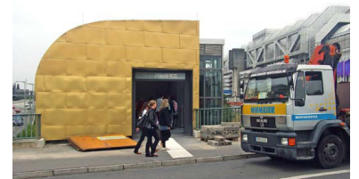
Endlich: Öffnung des neuen Zugangs am S-Bhf Messe Nord/ICC. Der Fußweg vom S-Bahnhof zum ICC und Messegelände ist damit bedeutend bequemer. (Foto: Marc Heller, 15.6.2009)
