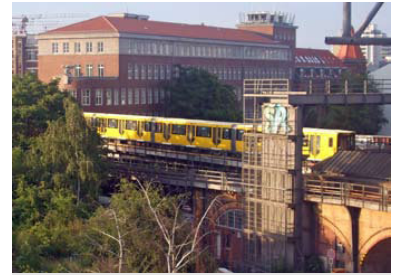
U-Bahn zwischen Potsdamer Platz und Gleisdreieck. Der ab 1991 in Berlin regierende CDU-SPD-Senat nutzte EU-Fördermittel, um diese Strecke wieder aufzubauen. Der derzeitige rot-rote Senat verzichtet auf EU-Gelder für den ÖPNV. (Foto: Marc Heller)
