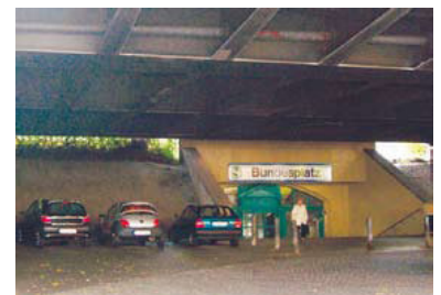
Wie der Stadtautobahnbau die Stadt zerstört hat, sieht man am S-Bahnhof Bundesplatz. Ähnliches droht nun am S-Bahnhof Treptower Park. (Foto: Martin Schlegel)
