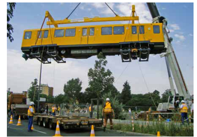
Die acht Fahrzeuge gelangten per Kran durch die Materialeinlassöffnung in den Tunnel, denn einen Gleisanschluss zum U-Bahn-Netz hat die U 55 nicht.
