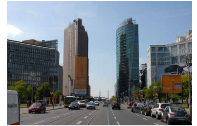
Leipziger Straße. Hier liegen bereits Straßenbahngleise für die Tram vom Alex zum Kulturforum. Aber wenn auf dem Mittelstreifen der Potsdamer Straße der Boulevard der Stars gebaut wird, dann kann hier keine Straßenbahn fahren. (Foto: Marc Heller)
