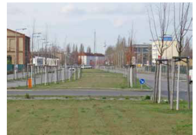
Beim Ausbau des Groß-Berliner Damms ist die Straßenbahntrasse bereits berücksichtigt worden, so dass hier mithilfe der einbehaltenen S-Bahn-Gelder umgehend Gleise gelegt werden können, um die Tram von der Wissenschaftsstadt Adlershof nach Schöneeweide zu führen. (Foto: Matthias Horth)
