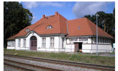
Usedomer Bäderbahn, Bf Trassenheide. Egal, wo der Fahrgast auf dem Streckennetz der Usedomer Bäderbahn (UBB) ein- oder aussteigt: Jeder Bahnhof bzw. Haltepunkt erfüllt einen hohen Standard, Ausreißer gibt es nicht. In den umfassend sanierten historischen Empfangsgebäuden sind diverse Serviceeinrichtungen untergebracht.
