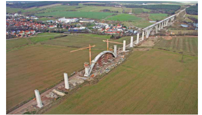
Die Ilmtalbrücke ist Bestandteil der Neubaustrecke Ebensfeld--Erfurt. Ab 2017 sollen hier die Hochgeschwindigkeitszüge Nürnberg--Berlin verkehren. Die 1681 m lange und rund 50 m hohe Brücke wird allerdings bereits 2011 fertiggestellt sein. Die Neubaustrecke verbucht auch einen neuen deutschen Rekord: Der Brücken- bzw. Tunnelanteil an der Gesamtstreckenlänge liegt bei rund 50 Prozent, was zwangsläufig zu überdurchschnittlichen Baukosten führt. (Foto: DB AG)
