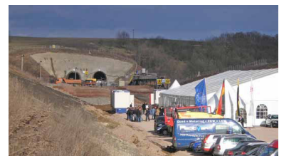
Der Bibratunnel ist Bestandteil der Neubaustrecke Erfurt--Leipzig/Halle, die ab 2015 befahren werden soll. Der Tunnel erhält zwei jeweils 6466 m lange Röhren. Am 3. März 2010 konnte der Durchschlag gefeiert werden. (Foto: Christian Schultz)
