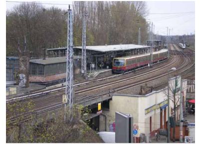
S3 auf der Fahrt nach Erkner am S-Bahnhof Berlin-Köpenick. Für den Regionalverkehr wird südlich davon (rechts) ein Mittelbahnsteig zwischen den durchgehenden Hauptgleisen des Fern-, Regional- und Güterverkehrs gebaut. (Foto: Christian Schultz)
