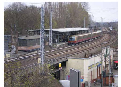
S3 auf der Fahrt nach Erkner am S-Bahnhof Berlin-Köpenick. Für den Regionalverkehr wird südlich davon (rechts) ein Mittelbahnsteig zwischen den durchgehenden Hauptgleisen des Fern-, Regional- und Güterverkehrs gebaut. (Foto: Christian Schultz)
