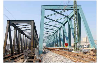
Rheinbrücke bei Kehl. Die Zunahme im grenzüberschreitenden Eisenbahnverkehr Deutschland/Frankreich wird derzeit durch die beiden nebeneinander stehenden Brücken sehr anschaulich: eingleisig die alte, zweigleisig die neue. (Foto: Pit Köther)
