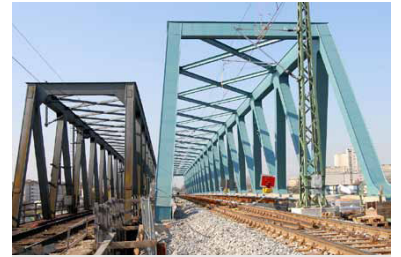
Rheinbrücke bei Kehl. Die Zunahme im grenzüberschreitenden Eisenbahnverkehr Deutschland/Frankreich wird derzeit durch die beiden nebeneinander stehenden Brücken sehr anschaulich: eingleisig die alte, zweigleisig die neue. (Foto: Pit Köther)
