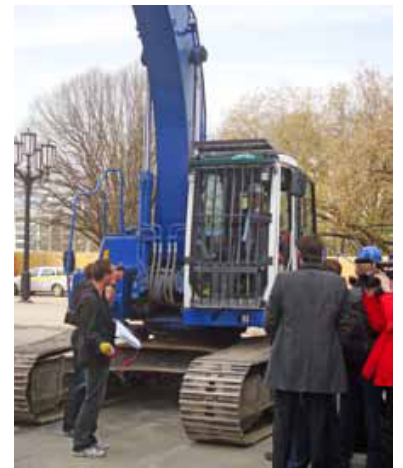
Wowi mit dem Bagger: Den ersten Rammschlag für den U-Bahnhof Berliner Rathaus führte der Regierende Bürgermeister Klaus Wowereit höchstpersönlich aus. (Foto: Florian Müller)
