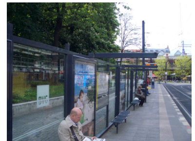
Wartehalle ohne Dach am Hackeschen Markt. Monatelang wurden die Straßenbahnfahrgäste im Regen stehen bzw. sitzen gelassen. (Foto: Holger Mertens)
