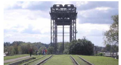
Karniner Brücke. Der Wiederaufbau der Strecke Ducherow--Swinoujscie (Swinemünde) ermöglicht auch eine verbesserte Erschließung von Usedom. Orte wie Karnin, Usedom und auch der Flughafen Heringsdorf (Garz) würden künftig direkt mit der Bahn erreichbar sein. (Foto: Christian Schultz)
