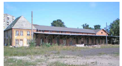
Empfangsgebäude Swinemünde Hbf. Mit Ausnahme des Stadtgebietes von Swinoujscie kann die alte Bahntrasse wieder genutzt werden. Die heutige Bebauung lässt die Nutzung des ehemaligen Hauptbahnhofes von Swinemünde leider nicht mehr zu. (Foto: Christian Schultz)
