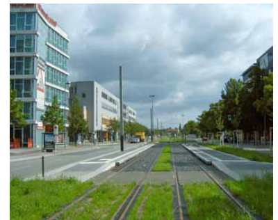
Im Frühjahr 2011 wird die Straßenbahnneubaustrecke in die Wissenschaftsstadt Adlershof endlich fertig. Dann muss mithilfe der einbehaltenen S-Bahn-Gelder sofort mit der Verlängerung zum Bahnhof Schöneweide begonnen werden. (Foto: Frank Lammers)
