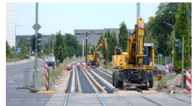
Sanierung der Straßenbahntrasse in der Falkenberger Chaussee. Wegen des hohen Sanierungsbedarfs werden auch künftig monatelange Unterbrechungen bei Straßenbahn, U-Bahn und S-Bahn erforderlich sein. Unzureichend sind dabei häufig die Organisation des SEV und vor allem die Fahrgastinformation. Entsprechende Vorgaben für Qualitätsstandards sieht auch der neue Nahverkehrsplan leider nicht vor. (Foto: Matthias Horth)
