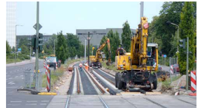
Sanierung der Straßenbahntrasse in der Falkenberger Chaussee. Wegen des hohen Sanierungsbedarfs werden auch künftig monatelange Unterbrechungen bei Straßenbahn, U-Bahn und S-Bahn erforderlich sein. Unzureichend sind dabei häufig die Organisation des SEV und vor allem die Fahrgastinformation. Entsprechende Vorgaben für Qualitätsstandards sieht auch der neue Nahverkehrsplan leider nicht vor. (Foto: Matthias Horth)
