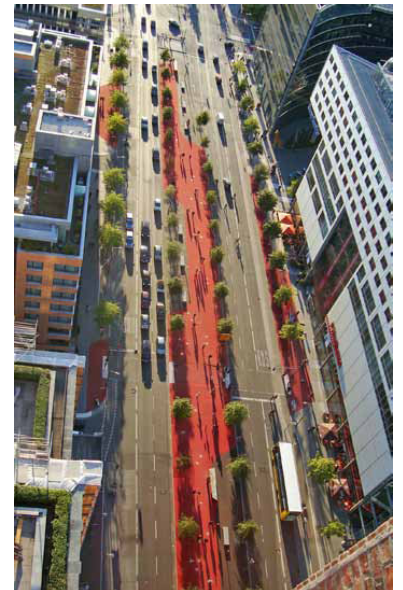
Das Luftbild der Potsdamer Straße verdeutlicht, dass der Boulevard der Stars der Straßenbahn weichen muss, wenn diese endlich vom Alexanderplatz über Potsdamer Platz zum Kulturforum verlängert wird. (Foto: Florian Müller)
