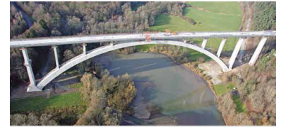
Talbrücke über den oberfränkischen Froschgrundsee auf der Neu- und Ausbaustrecke Nürnberg--Berlin. Während die Brücke bereits 2006 bis 2010 gebaut wurde, kann der Abschnitt Ebersfeld--Erfurt, zu dem diese Brücke gehört, nicht vor 2017 befahren werden. Aber wegen des Baufortschritts auf dieser extrem teuren Neubaustrecke gibt es kein Zurück mehr, obwohl nach der für das Umweltbundesamt erstellten Studie die hier verbauten Milliarden andernorts sehr viel effizienter einsetzbar wären. (Foto: DB AG)
