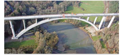
Talbrücke über den oberfränkischen Froschgrundsee auf der Neu- und Ausbaustrecke Nürnberg--Berlin. Während die Brücke bereits 2006 bis 2010 gebaut wurde, kann der Abschnitt Ebersfeld--Erfurt, zu dem diese Brücke gehört, nicht vor 2017 befahren werden. Aber wegen des Baufortschritts auf dieser extrem teuren Neubaustrecke gibt es kein Zurück mehr, obwohl nach der für das Umweltbundesamt erstellten Studie die hier verbauten Milliarden andernorts sehr viel effizienter einsetzbar wären. (Foto: DB AG)
