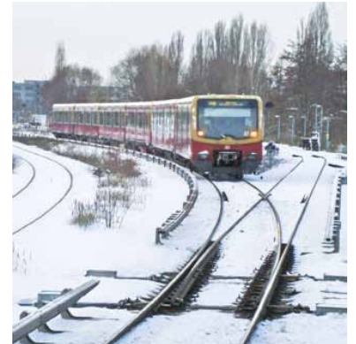
Aufgetaute Weiche in Tempelhof. Doch allzu oft versagten die Weichenheizungen und behinderten den Fahrbetrieb der S-Bahn massiv.
